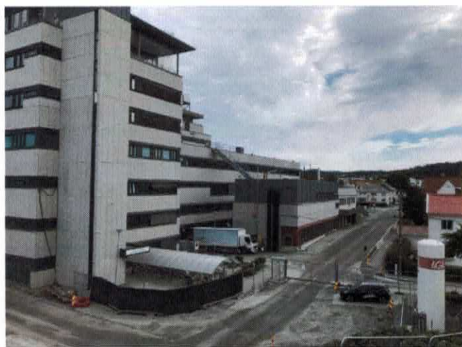
Bilde Energisentral sett fra sydvest.
