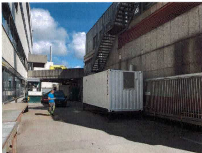
Bilde. Container på plass ved energisentral i bakgård.
