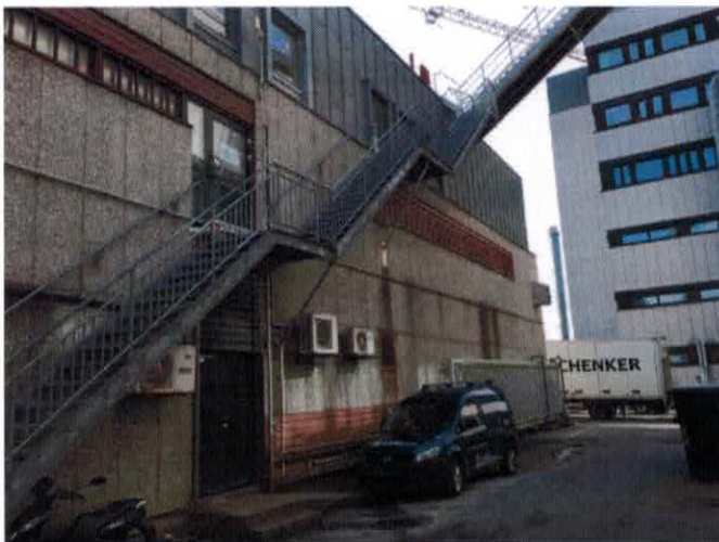
Bilde. Bakgård bak energisentral hvor container vil bli plassert.
