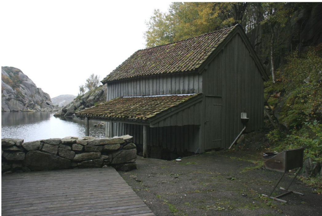
Sjøbu innredet med langbord
