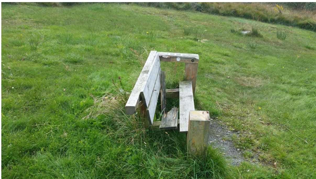
Benk ved toppen som trenger vedlikehold.
